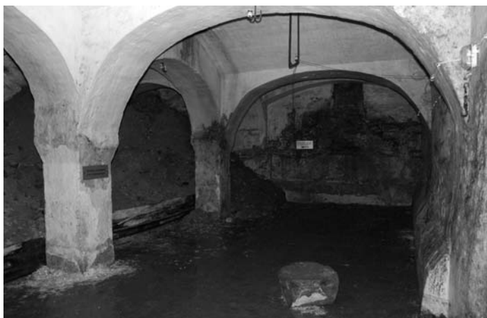
Rys. 7. Widok ogólny komory (1) w dawnym Więzieniu
