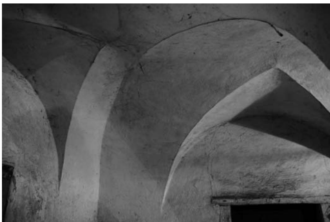
Rys. 5. Widok sklepienia piwnicy w danym Wójtostwie
