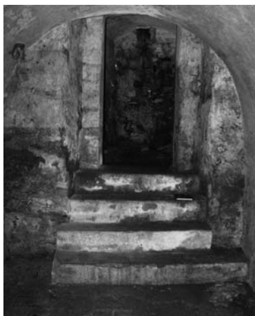
Rys. 2. Zejście schodowe w obiekcie na ul. Siemiradzkiego 6
