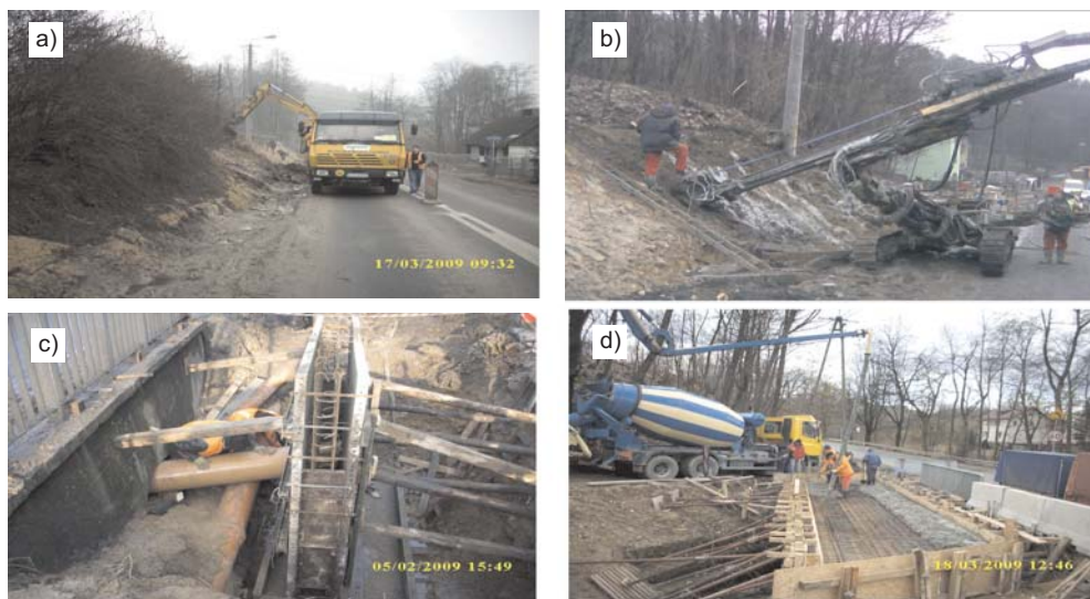
Rys. 9. Fotografie z wykonywanych robót drogowych: a) gwoździowanie skarp; b) profilowanie skarp; c) przebudowa przepustu drogowego; d) wykonywanie kładki dla pieszych
