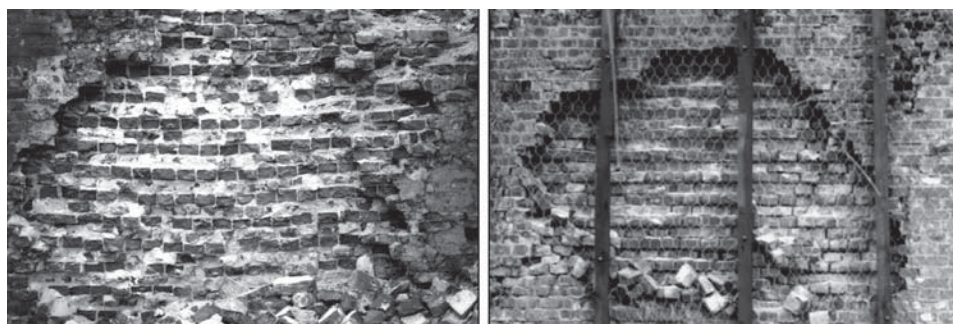
Rys. 10. Fotografie przedstawiające mur przed i po zastosowaniu zabezpieczenia z siatki gabionowej
