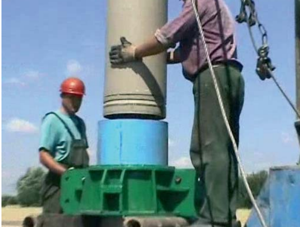
Rys. 1. Zapuszczanie rur poliestrowych Hobas do studni odwadniającej
