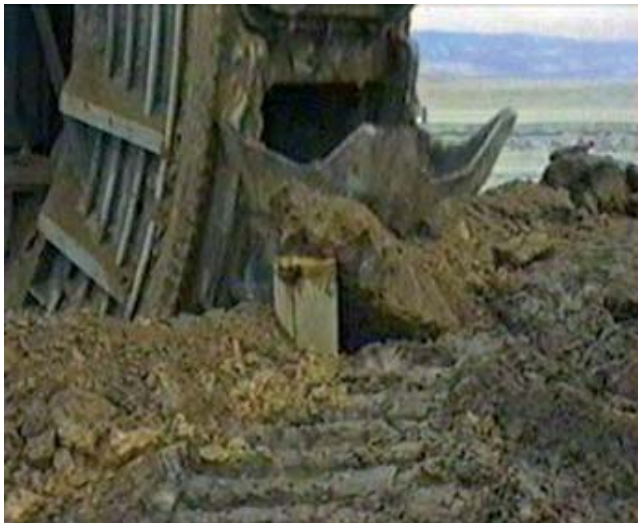
Rys. 2. Widok ucinanej kolumny rur z żywicy poliestrowych przez koło urabiające koparki
