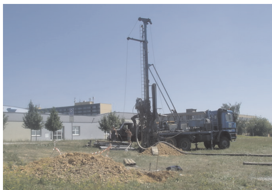
Rys. 3. Wiertnica typu NORDMAYER DBS 2/10. Wiercenie otworu monitorującego E3
