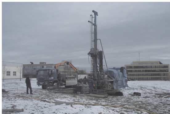
Rys. 2. Wiertnica typu NORDMAYER DBS 2/10. Wiercenie centralnego otworu monitorującego na terenie VSB-TU
