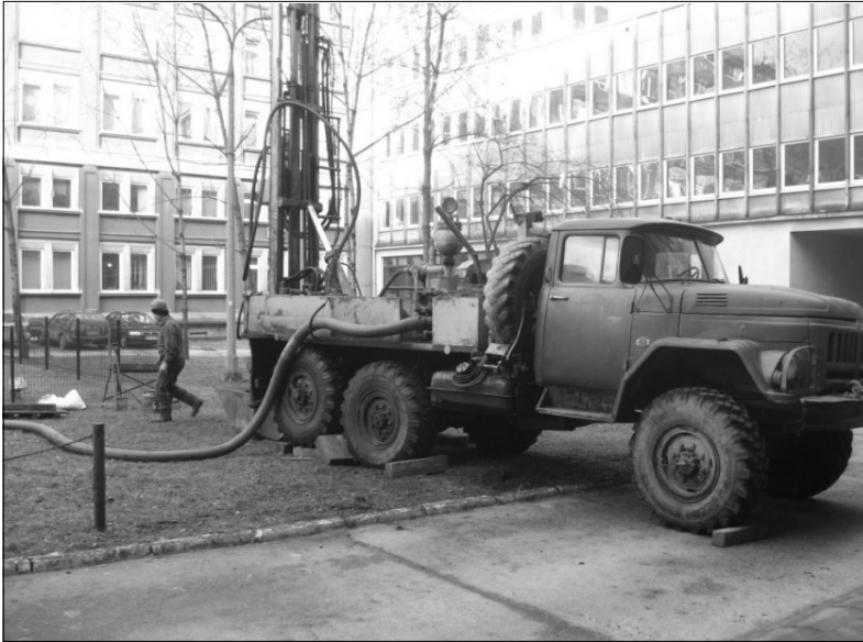
Rys. 1. Wykonywanie otworowego wymiennika ciepła otwór AGH LG2
