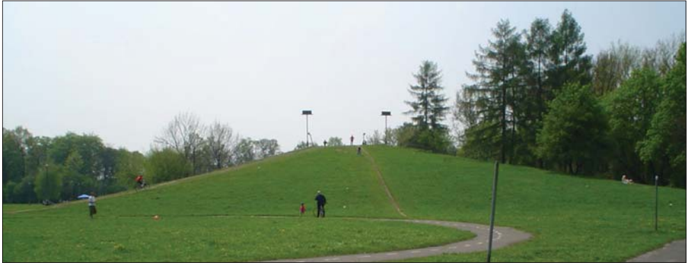
Rys. 5. Widok mierzonego obiektu od strony stoku północnego
