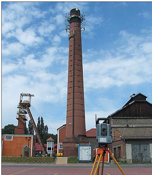
Rys. 1. Widok inwentaryzowanego komina ceglanego w KS „Bochnia” (obok szybu Campi) oraz tachimetru skanującego VX Trimble
