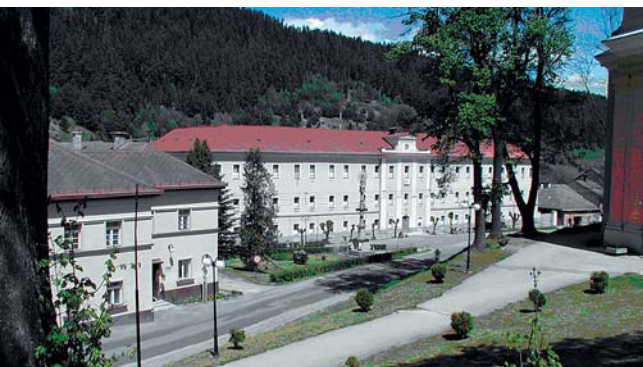
Fig. 9. The Kamerhof – the former seat of court chamber at Smolník destroyed by fire in 1880 and reconstructed into tobacco factory, phot. T. Sasvári • Kamerhof – dawna siedziba sądu w Smolniku zniszczona przez pożar w roku 1880 i przebudowana na fabrykę tytoniową, fot. T. Sasvári
