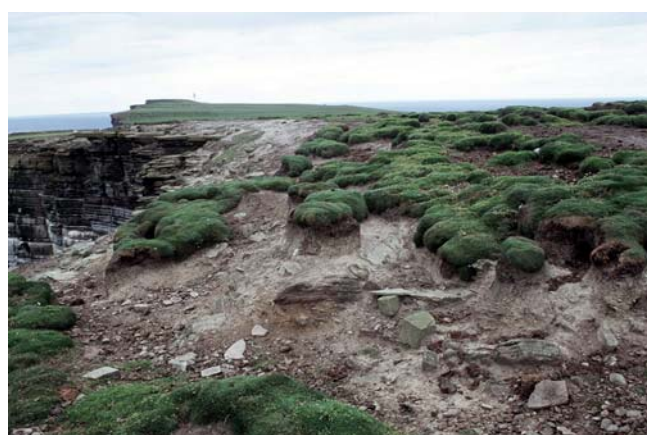
Fig. 20. Działalność fal sztormowych sięga wysoko na szczytowe partie klifów, niszcząc pokrywę roślinną (Westray, Orkady), fot. A. Latocha • Destructive action of storm waves reaches the clifftops, stripping away the vegetation (Westray, Orkney), phot. A. Latocha
