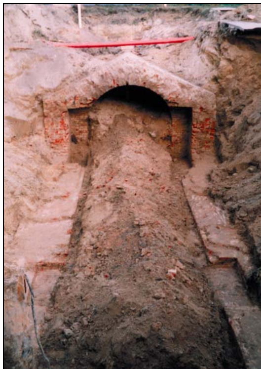
Rys. 4. Odkrywka zachodniego końca tunelu fortecznego przygotowana do inwentaryzacji. Widoczne fundamenty rozebranej części tunelu
