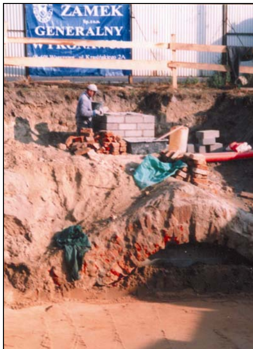
Rys. 8. Budowa szybiku nad rozcutym stropem
