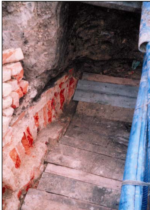
Rys. 7. Rozkuty strop poterny przygotowany do odtworzenia
