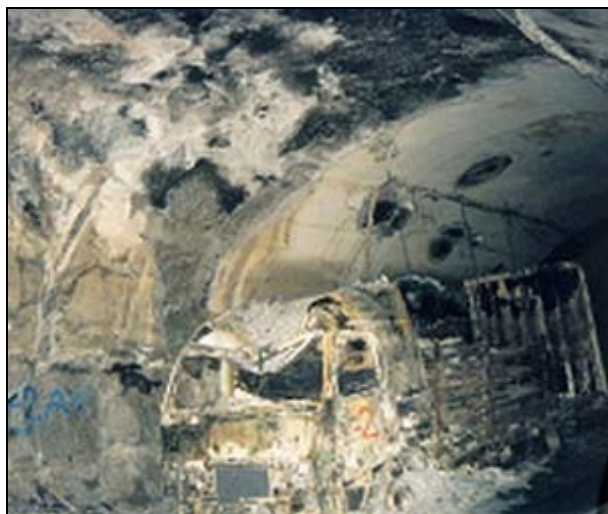
Rys. 1. Karoseria ciężarówki po pożarze w tunelu Mont Blanc
