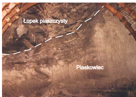
Rys. 3. Widok czoła przekopu łączącego 1 w skrzydle zrzuconym po przejechaniu uskoku andaluzyjskiego
