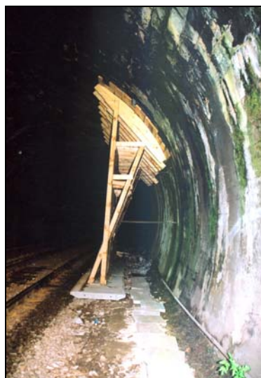
Rys. 2. Konstrukcja drewniana doraźnie podpierająca i zabezpieczająca uszkodzone sklepienie w miejscu awarii (segment III): a) widok od strony wnętrza tunelu; b) widok od strony portalu wlotowego (Tarnów)
