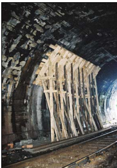
Rys. 2. Konstrukcja drewniana doraźnie podpierająca i zabezpieczająca uszkodzone sklepienie w miejscu awarii (segment III): a) widok od strony wnętrza tunelu; b) widok od strony portalu wlotowego (Tarnów)
