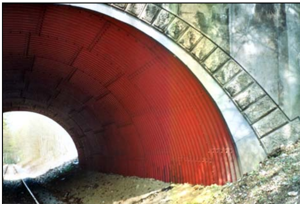
Rys. 8. Wzmocnienie i zabezpieczenie sklepienia tunelu kolejowego za pomocą powłoki stalowo-betonowej z blach falistych i betonu samozagęszczalnego (Niemcy)
