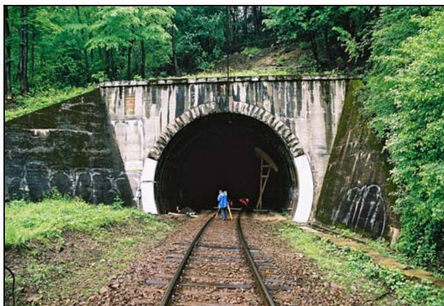
Rys. 1. Portal i wjazd do tunelu w Kamionce Wielkiej od strony Tarnowa. Widok ogólny
