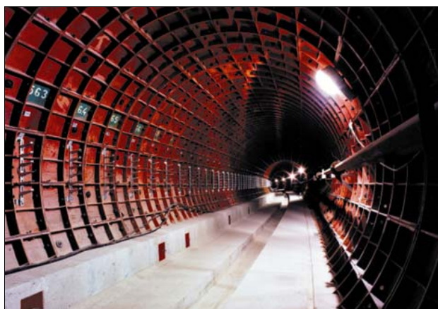
Rys. 3. Metro Warszawskie — tunel w obudowie tubingowej
