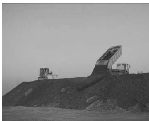
Rys. 7. Transport materiału i formowanie hałdy: a) transport materiału skalnego; b) transport płynnych szlamów poflotacyjnych
