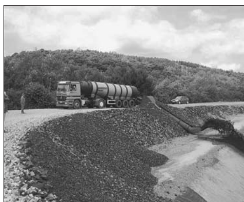
Rys. 7. Transport materiału i formowanie hałdy: a) transport materiału skalnego; b) transport płynnych szlamów poflotacyjnych
