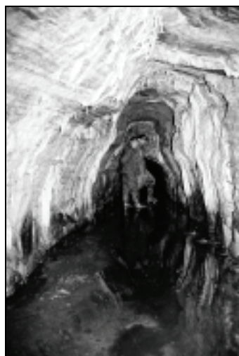
Rys. 2. Odcinek Sztolni bez obudowy (fot. M. Lesiak)
