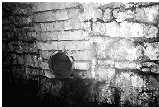
Rys. 5. Podłączenia kanalizacyjne do Sztolni (fot. W. Preidl)
