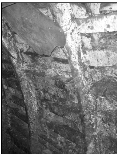
Rys. 1. Skorodowany łuk ociosowy
