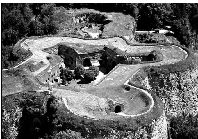
Rys. 5. Widok Donżonu z ubytkami krawężnika muru zewnętrznego
