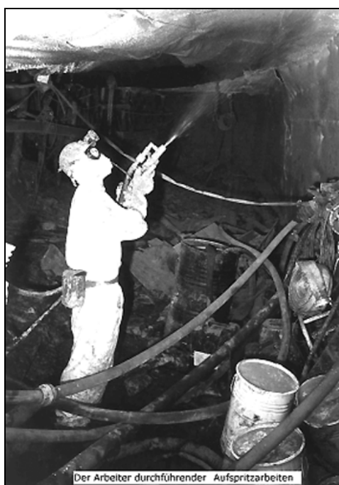
Rys. 3. Natrysk elastycznej żywicy organiczno-mineralnej
