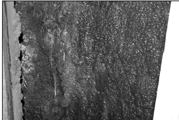
Rys. 2. Stan obudowy na poziomie dźwigara nr 123
