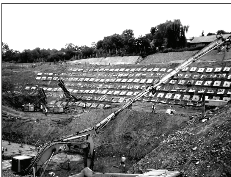
Rys. 7. Wzmacnianie skarpy głębokiego wykopu
