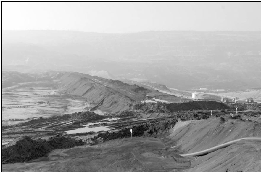
Rys. 2. Widok ze zbocza północnego na „groblę” usytuowaną na przedpolu zwałowiska wewnętrznego
