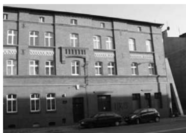
Rys. 4. Kamienica, Ruda Śląska, Wirek
