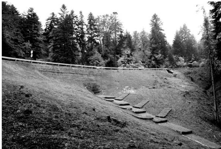
Rys. 9. Odbudowane osuwisko drogowe w miejscowości Polana
