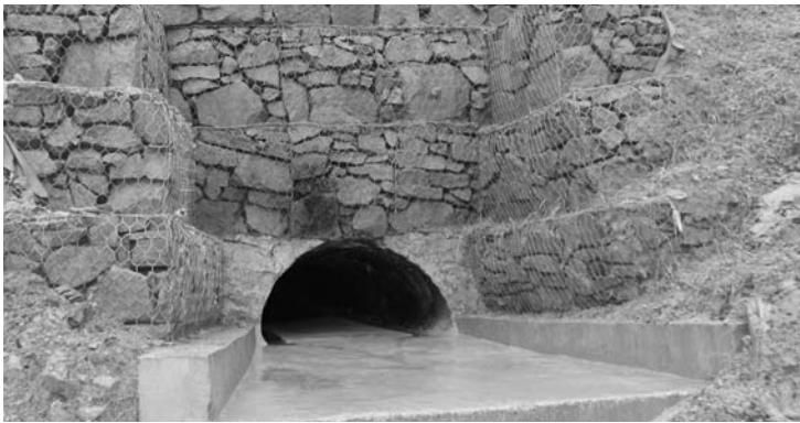
Rys. 8. Wylot przepustu umocniony koszami gabionowymi i płytą żelbetową
