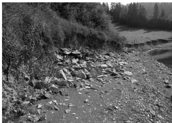
Rys. 2. Fragment obrzeża zbiornika w rejonie przekrojów I–I, II–II i III–III
