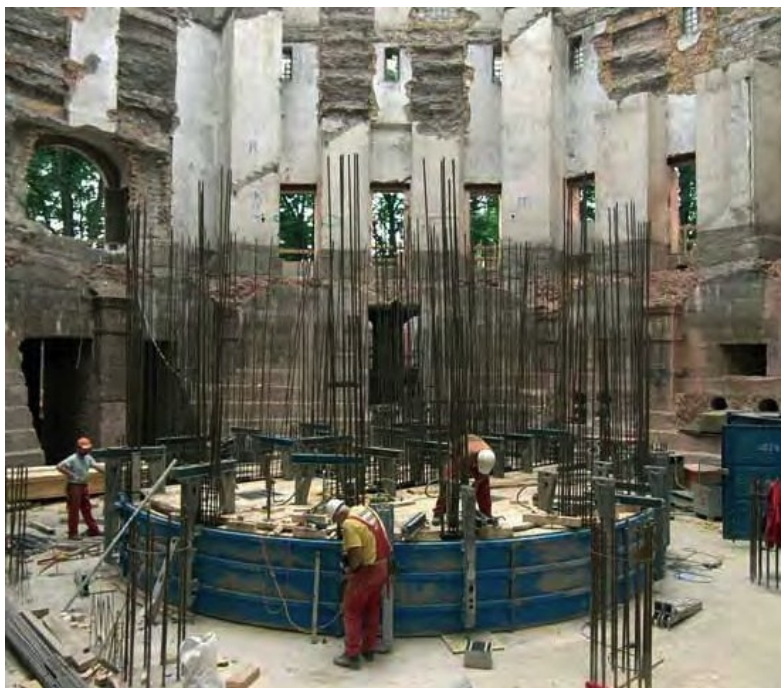
Rys. 8. Realizacja żelbetowego trzonu konstrukcyjnego wnętrza (fot. www.2bp.blogspot.com )
