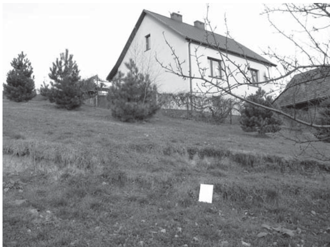
Rys. 1. Wygląd górnej części osuwiska. Powierzchnia poślizgu 14 m od narożnika domu mieszkalnego. Sumaryczne obniżenie dwóch tarasów — około 70 cm. Na pierwszym planie teczka tekturna
