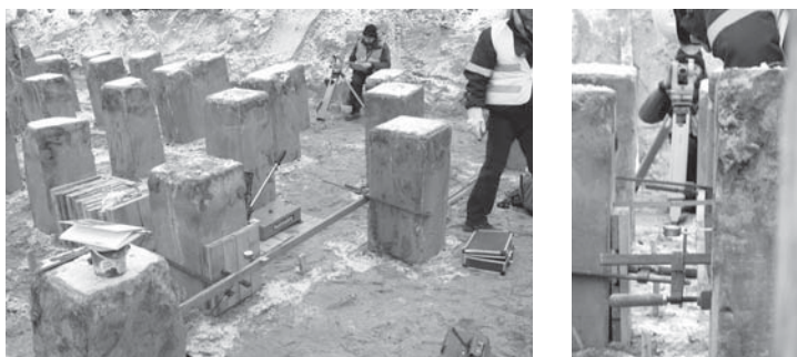
Rys. 8. Stanowisko do badań nośności bocznej pali prefabrykowanych
