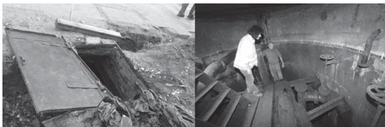
Rys. 1. Wejście i wnętrze historycznej przepompowni ścieków w Olsztynie (fot. J. Chmura)
