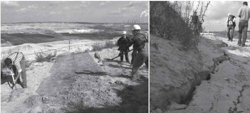
Rys. 4. Instalacja geosiatki pomiarowej z zintegrowanym sensorem POF na terenie Kopalni Węgla Brunatnego Bełchatów
