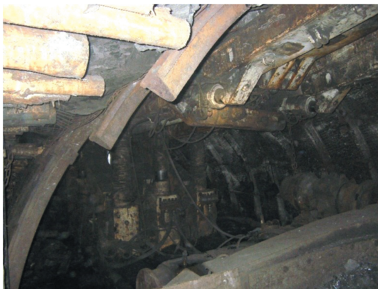
Rys. 1. Odrzwia obudowy łukowej typu ŁP z wypiętym łukiem ociosowym
